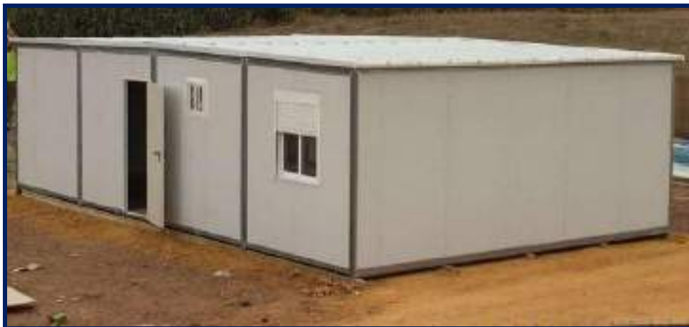
Ilustración 5 tipo de caseta y coloración de la caseta de control
