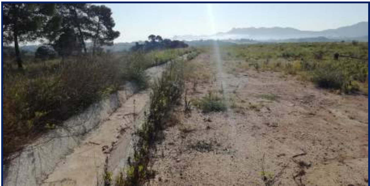
Ilustración 16 visión desde la zona norte del vertedero hacia el este, con detalle de las canaletas de drenaje.
